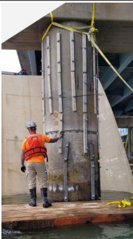
Hình 11 : đang lắp đặt cực kẽm
