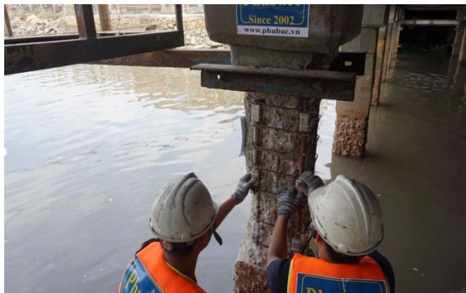
Hình 9 : đang lắp đặt cực kẽm
