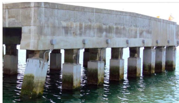
Hình 12 : các cực kẽm được bao bọc bởi lớp vữa và lớp FRP bên ngoài cùng
