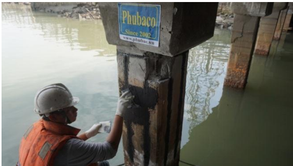
Hình 5 – gắn anode
