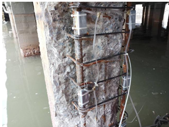
Hình 10 : đã lắp đặt cực kẽm xong
