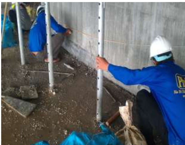
BƠM KEO XỬ LÝ KHE HỖ
