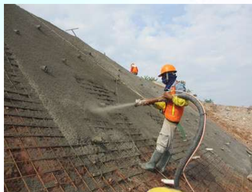
PHUN BÊ TÔNG MÁI TALUY
