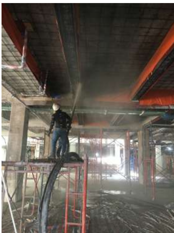
PHUN BÊ TÔNG NHÀ XƯỞNG
