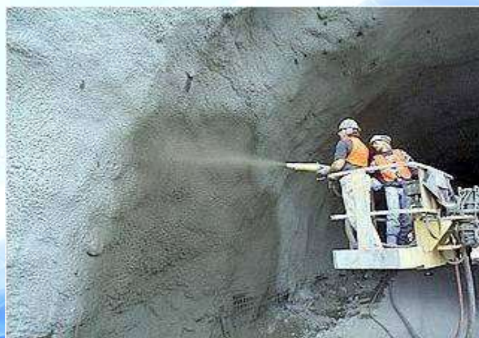
PHUN BÊ TÔNG ĐƯỜNG HẦM
