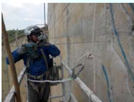
KHOAN BƠM KEO XỬ LÝ NÚT ĐẬP THỦY ĐIỆN
