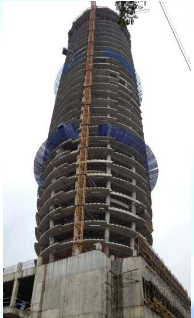
CÔNG TRÌNH ĐANG THI CÔNG
