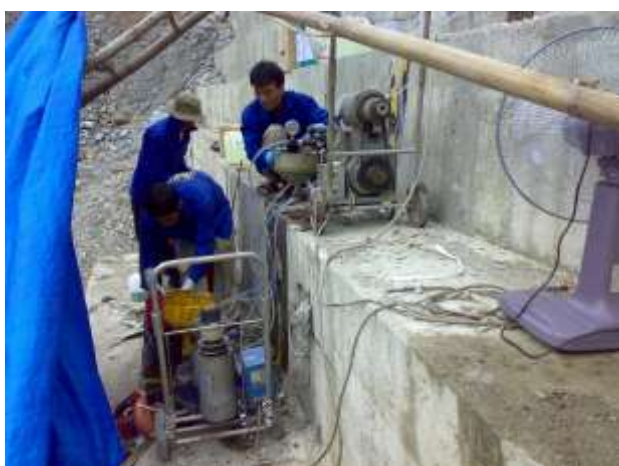
NÚT HÀNH LANG THỦY ĐIỆN
