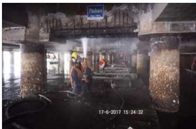
PHUN BÊ TÔNG GẦM CẦU CẢNG
