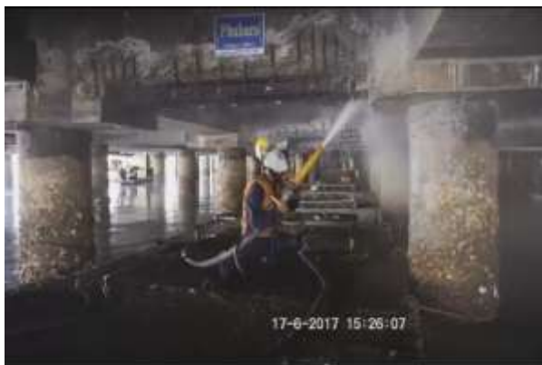
PHUN BÊ TÔNG
