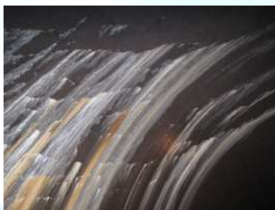
RÒ RỈ TRONG ỐNG DẪN NƯỚC THỦY ĐIỆN
