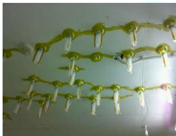
NÚT BÊ TÔNG SÀN NHÀ
