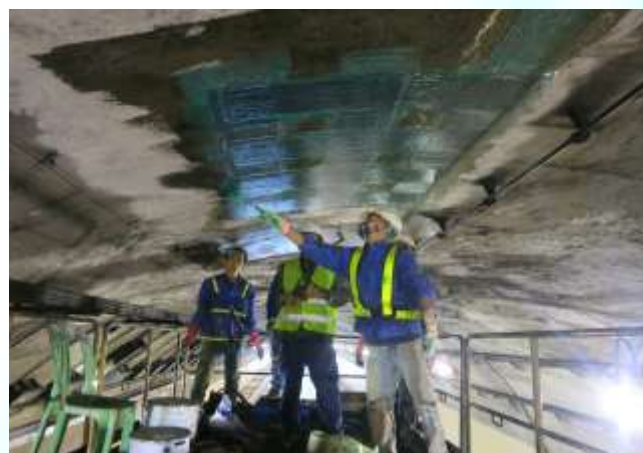
DÁN SỢI CARBON ĐƯỜNG HẦM
