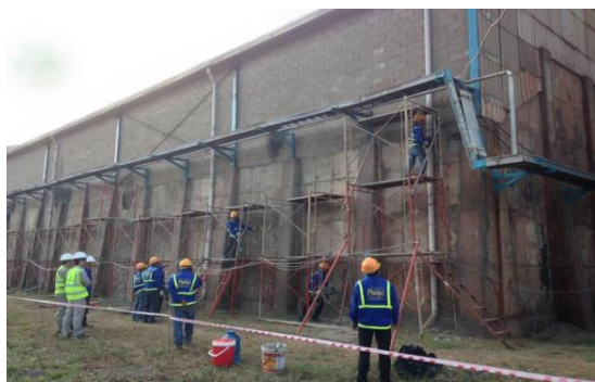
Toàn cảnh khu vực thi công
