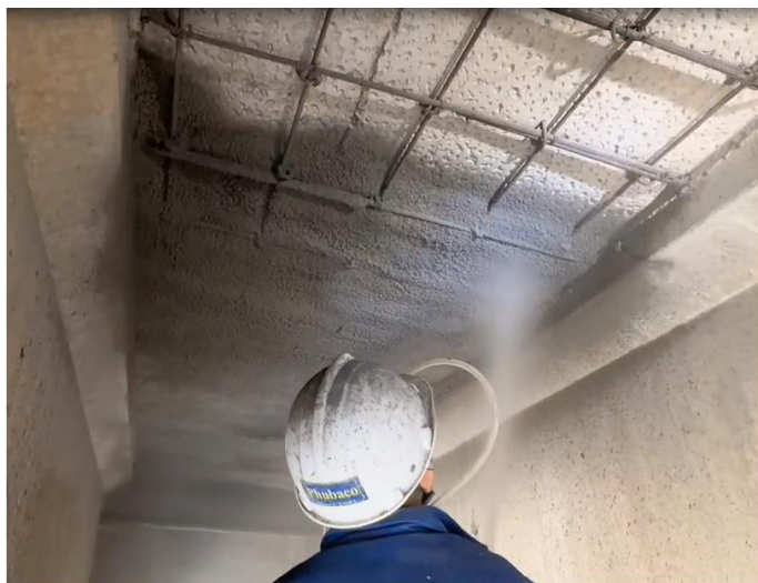
Phun bê tông găm cầu
