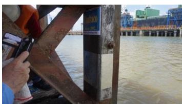
Kiểm tra chống ăn mòn cho kết cấu thép
