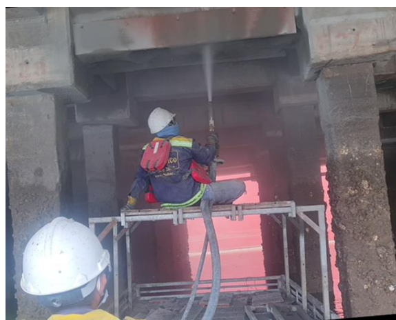
Phun bê tông đẩy dầm cầu cảng
