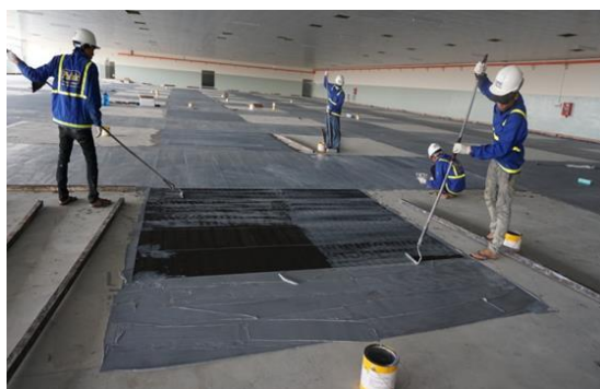
Thi công CFRP
