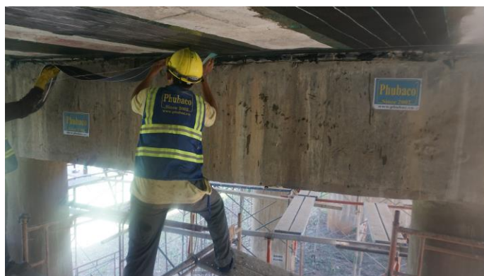
Gia cường cầu bằng sợi carbon
