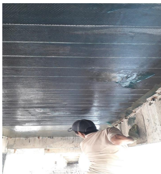
Thi công CFRP ở mặt dưới kết cấu
