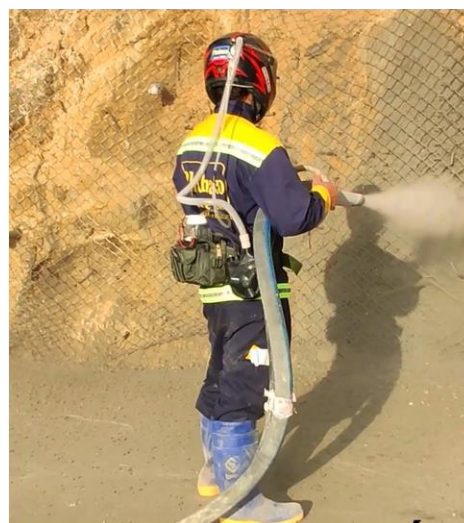
Phun bê tông mái/taluy
