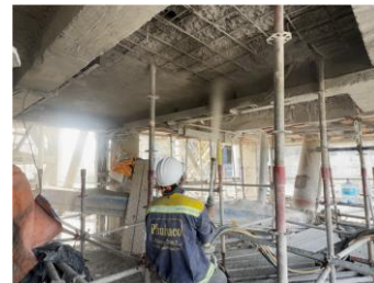
Phun bê tông sửa chữa đáy sàn nhà
