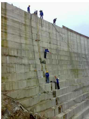
Xử lý nứt/thấm
