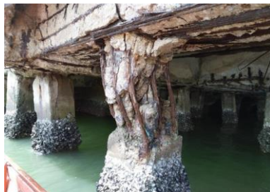
Sửa chữa BTCT tại cầu cảng
