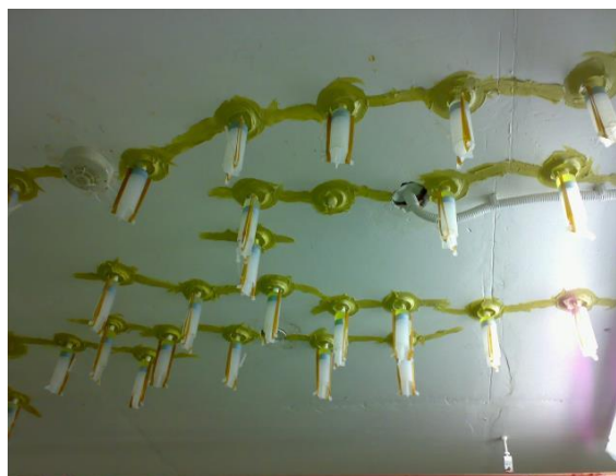
Bố trí đầu bơm xử lý nứt
