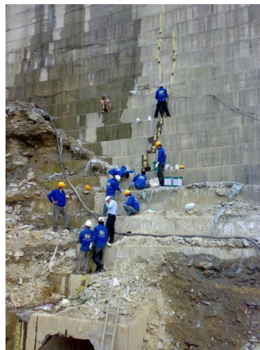
Thi công xử lý trên thân đập
