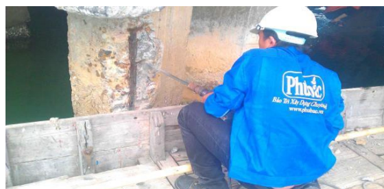
Sửa chữa bê tông tại cầu cảng
