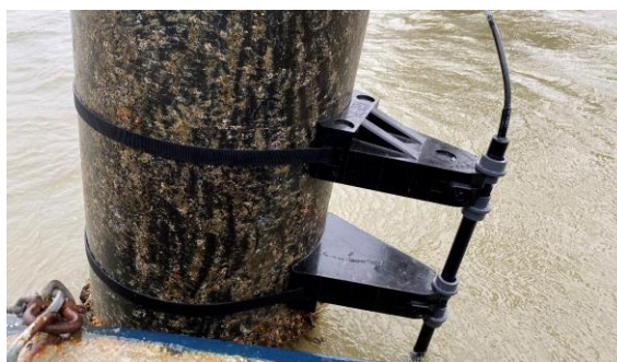
Chi tiết giá đỡ, thân anode và cáp anode
