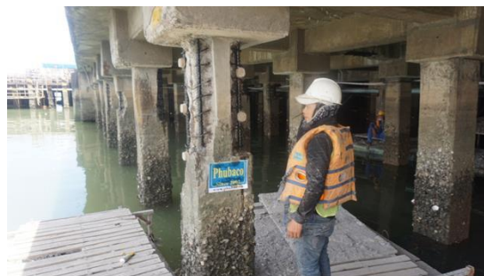
Kiểm tra hiện trạng tại cầu cảng
