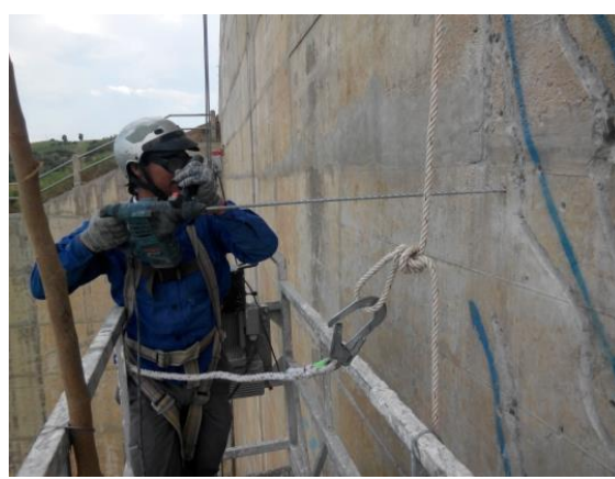
Khoan/bơm keo tại đập thủy điện
