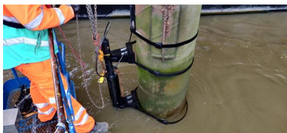
Lắp đặt cụm anode ICCP trên cọc thép
