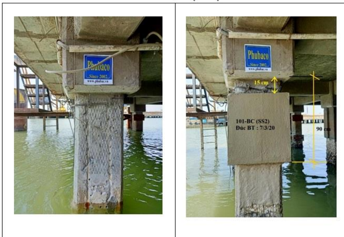
Đầu cọc BTCT: lưới Titan MMO trước khi phủ phục hồi và bề mặt sau hoàn thiện.
