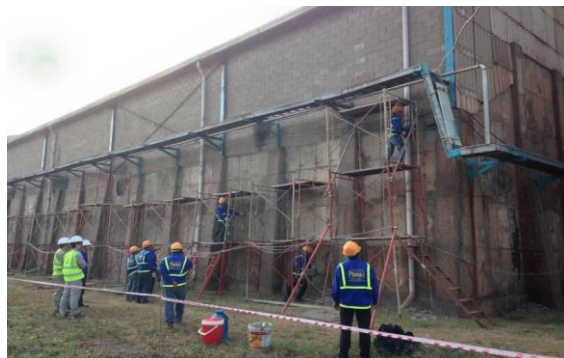
Công trường Nhà máy Phân bón Việt Nhật
