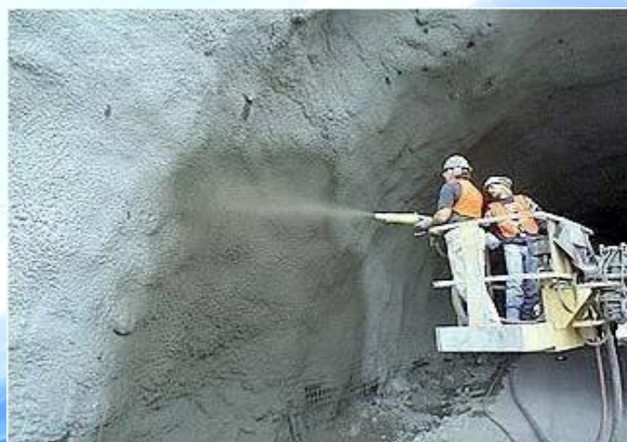
PHUN BÊ TÔNG ĐƯỜNG HẦM
