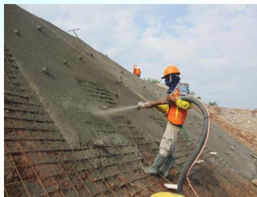
PHUN BÊ TÔNG MÁI TALUY
