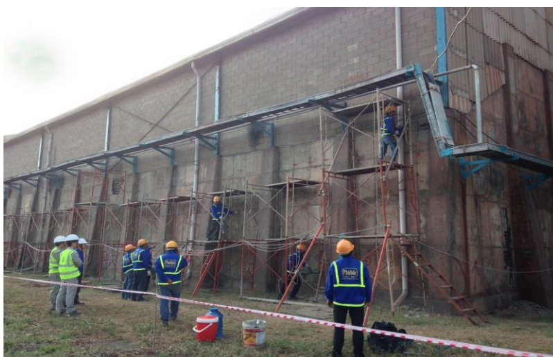
CÔNG TRƯỜNG BÊN NGOÀI NHÀ MÁY
