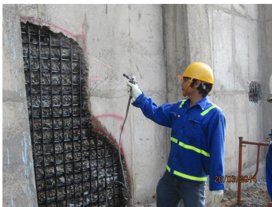
Hình : tái lập tường bê tông
