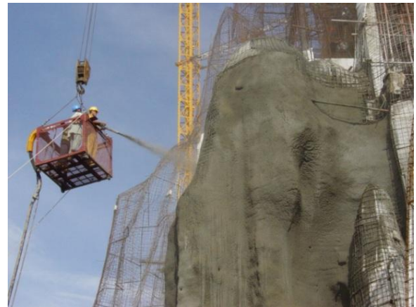
Hình : Phun bê tông mái dốc
