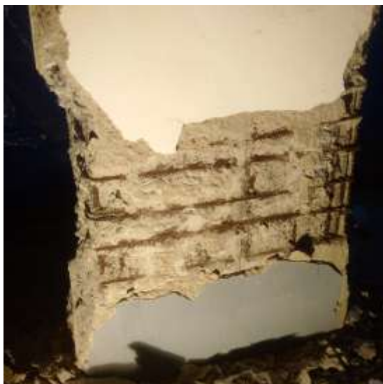
Cột nhà cao tầng
