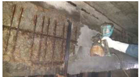
Phun lớp epoxy Maxepox Bond-S
