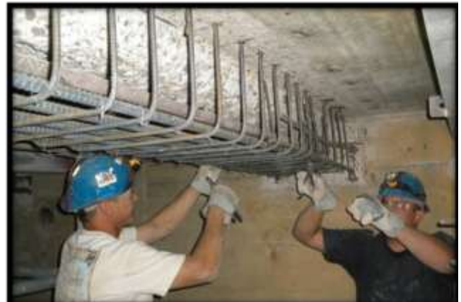
Khoan cấy thép vào bê tông
