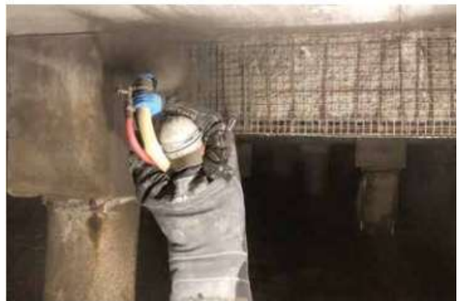
Phun bê tông thành dầm
