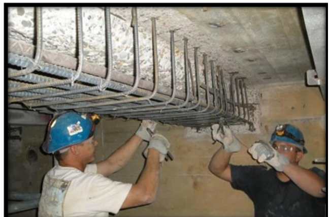
Khoan cấy thép vào bê tông
