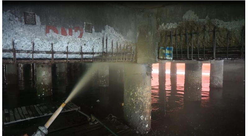
Đánh rỉ bằng máy nén khí + cát + nước
