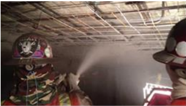
Phun bê tông đáy sàn
