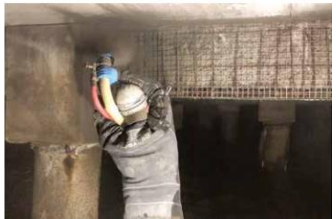
Phun bê tông thành dầm
