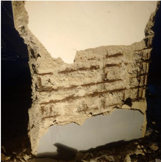
Cột nhà cao tầng
