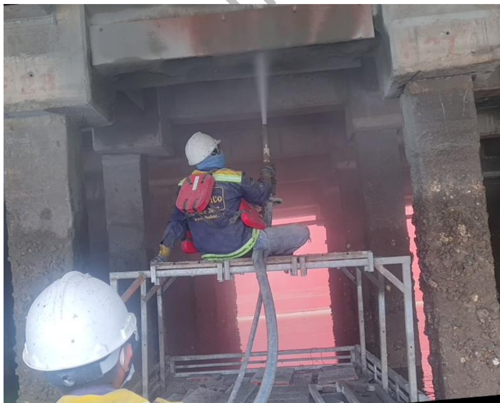
Hình 4 : Phun bê tông đáy dầm ,sàn cầu cảng
