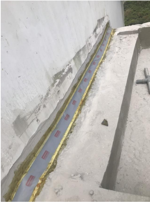
Hình 4 : Chống rò rỉ nước vị trí giữa tường gạch và sàn sân tượng
