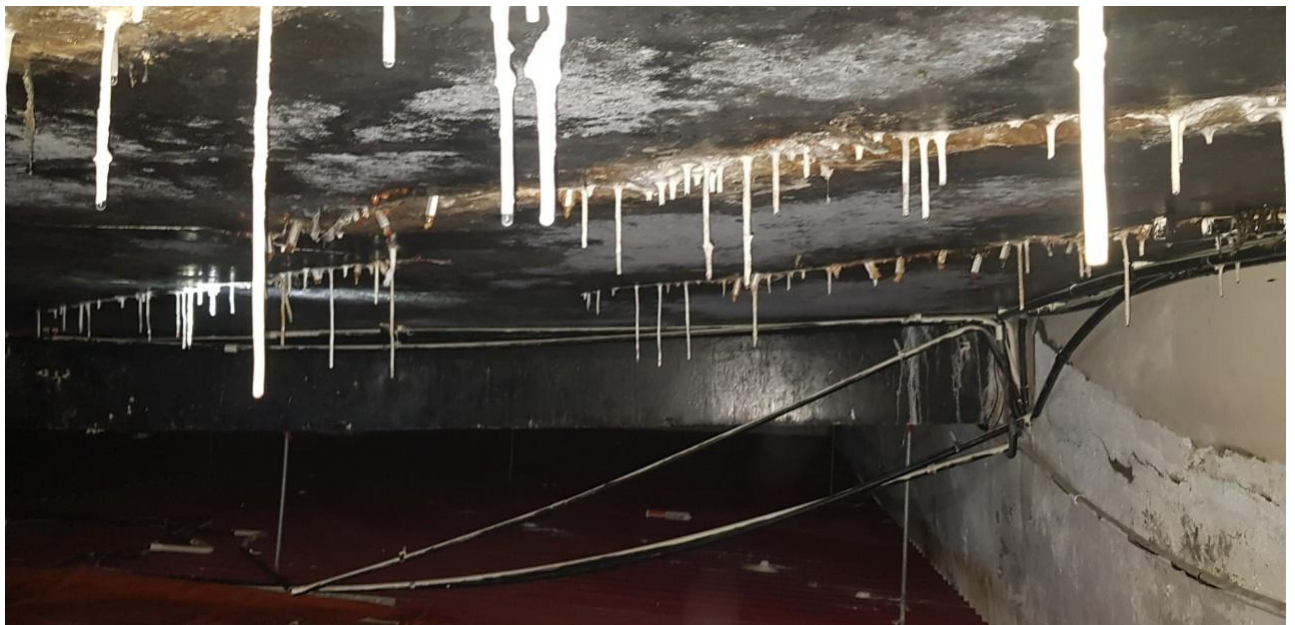
Hình 1 : Vết nứt sàn mái bị thấm sau một thời gian bơm bơm PU ( keo trương nở )
