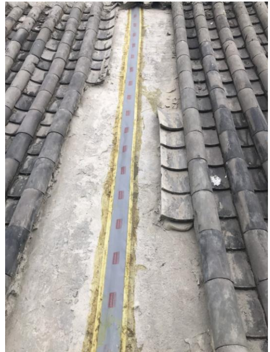
Hình 3 : Thi công thực tế ở công trình
