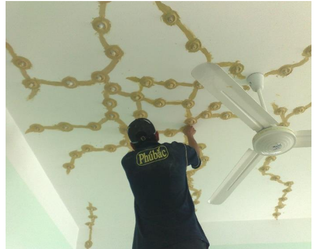
Hình 6 : Bơm epoxy sửa chữa vết nứt
