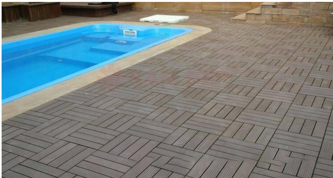
Hình 9 : Lớp gạch lắp ghép chuyên cho sàn mái ( không dán cứng xuống dưới sàn )
