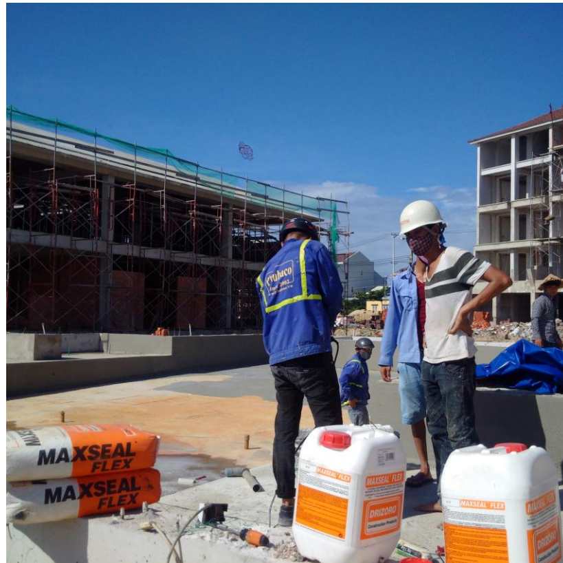
Hình 8 : Quét chống thấm sau khi thử thấm sàn
