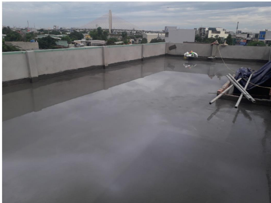
Hình 7 : Thử thấm kiểm tra chất lượng chống thấm của bê tông trước khi quét hóa chất chống thấm
