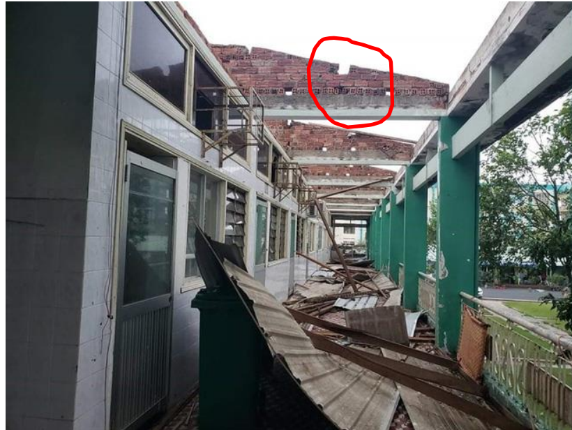
Hình 3 : Liên kết giữa xà gỗ và tường gạch đỡ mái kém
