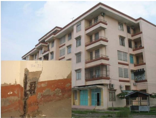
Hình 1 : Cốt thép ở chân cột chung cư bị ăn mòn sau 5 năm xây dựng
