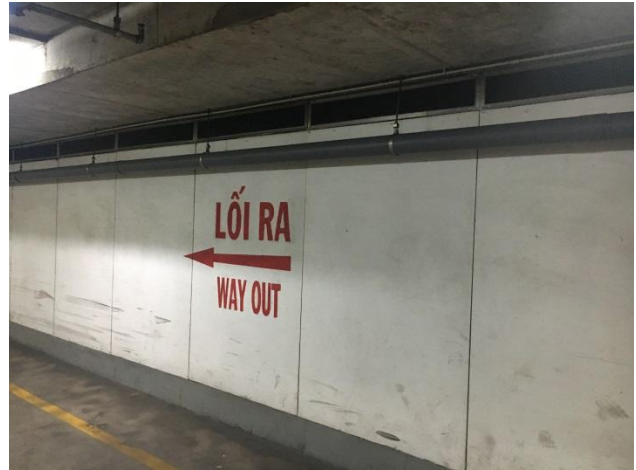
Tường trang trí và rãnh thoát nước tầng hầm
