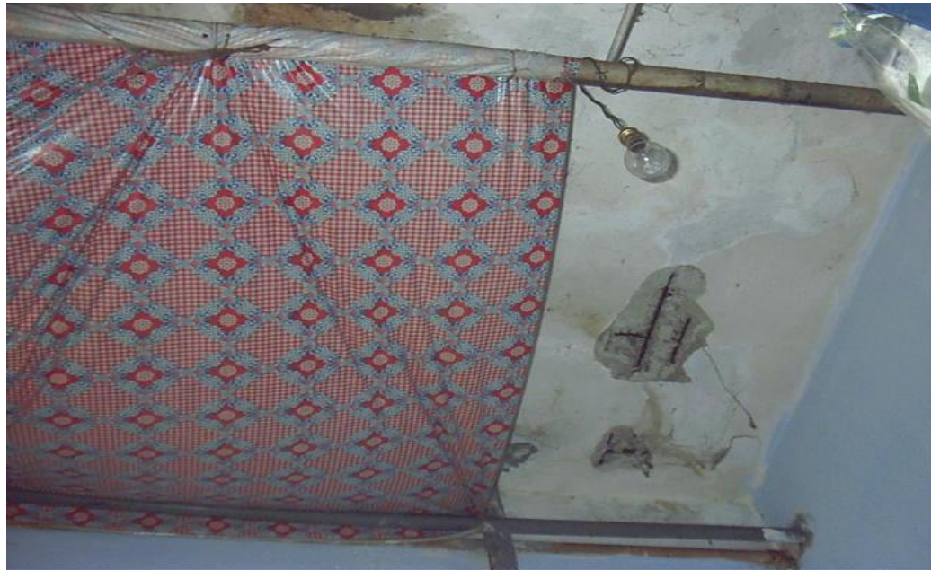
HÌNH 2 : Sàn vệ sinh bị thấm nước lâu ngày (phải dùng áo mưa chặn nước ) thép sàn bị rỉ bê tông nứt , sàn có nguy cơ bị sập
