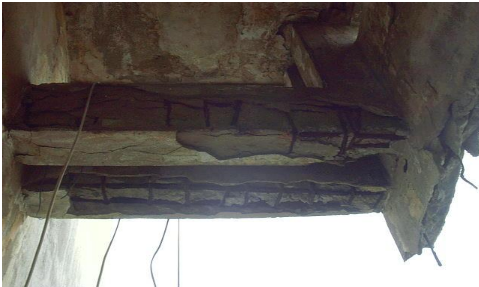
HÌNH 1 : Kết cấu khung sàn bê tông cốt thép trường ĐHSP TPHCM được xây dựng năm 1968 ( 37 năm sử dụng ) đã xuống cấp cấp trầm trọng có nguy cơ sập đổ
