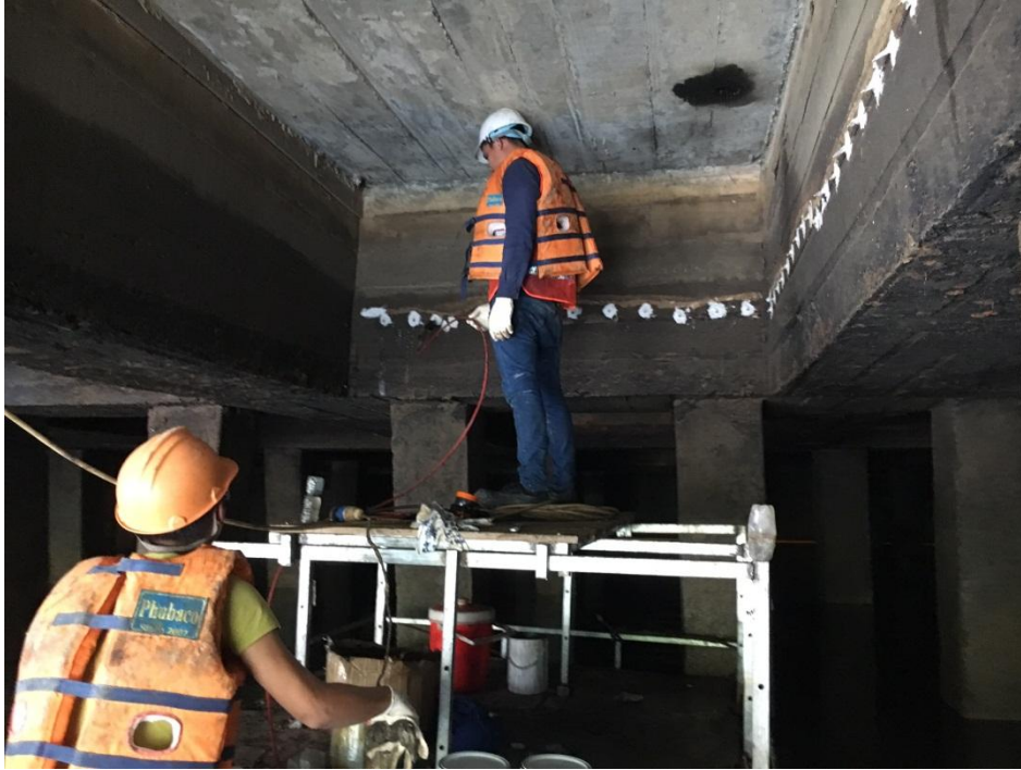
Đang bơm epoxy xử lý vết nứt dầm cầu cảng 10-2016
