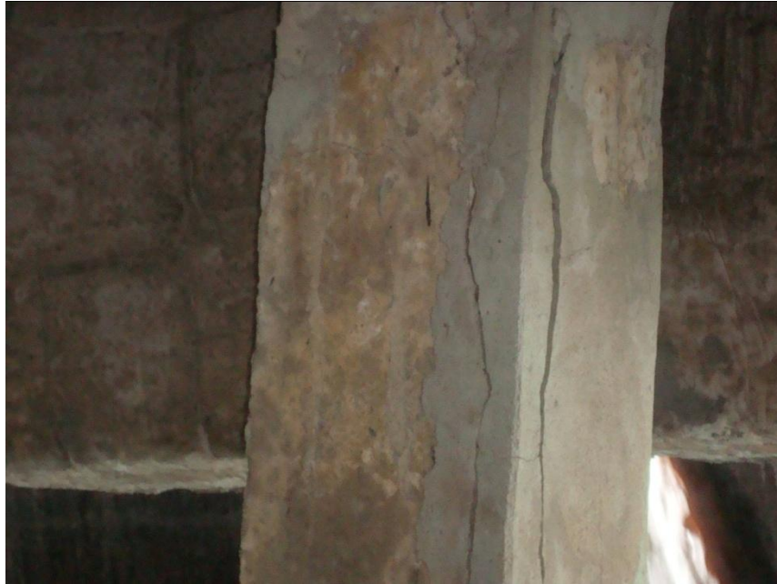
Hình 2 : Bệnh cũ tái phát sau khi sửa chữa bằng vữa thường
