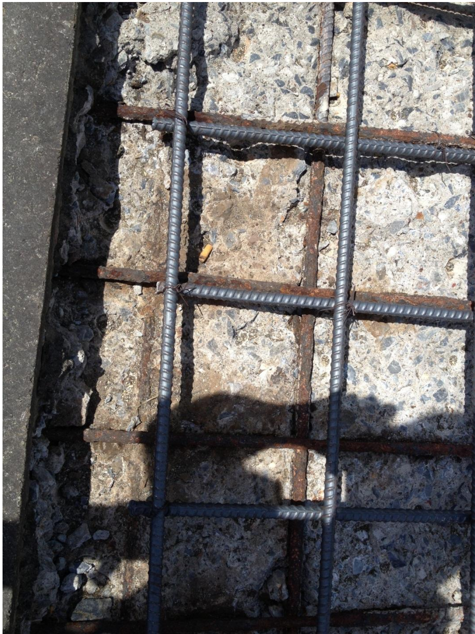
Hình ảnh đang sửa chữa lớp bê tông cốt thép bề mặt cảng bị ăn mòn
