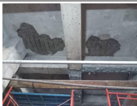
Bê tông hư hỏng do bị cháy
