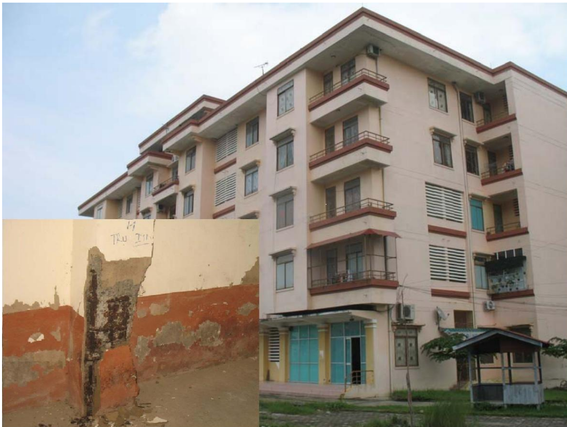
Hình 1 : Cốt thép ở chân cột chung cư bị ăn mòn sau 5 năm xây dựng
