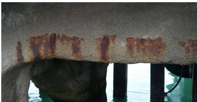
Hình 9 : Kết cấu bị ăn mòn
