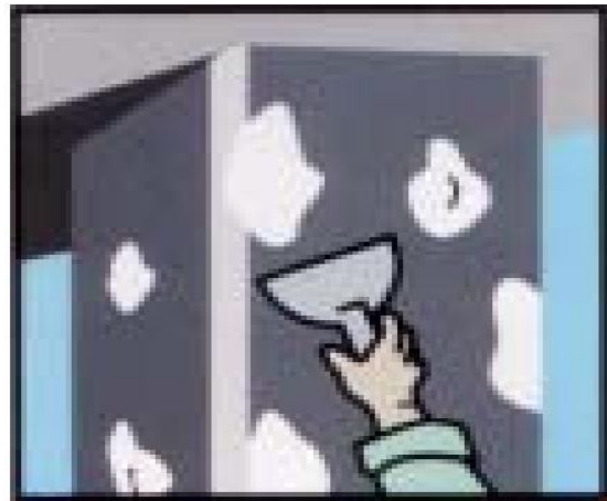
Hình 7 : trám trét lỗ mọt và tạo phẳng
