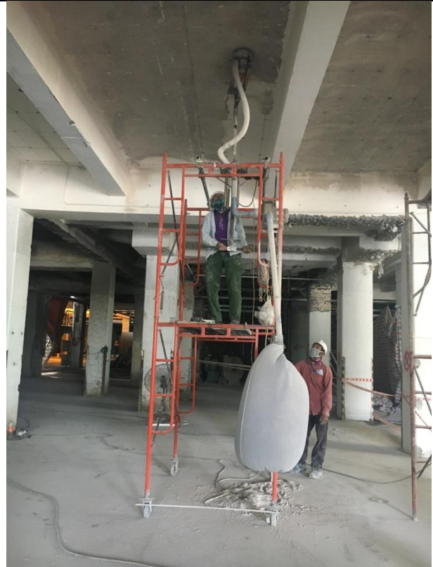
Hình 5: Mài đáy sàn , dầm bằng robot
