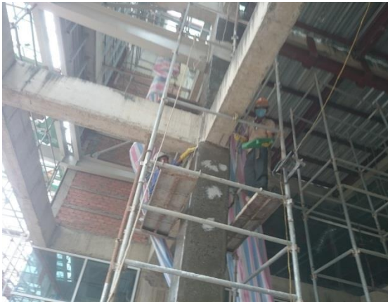
Hình 7 : trám trét lỗ mọt và tạo phẳng
