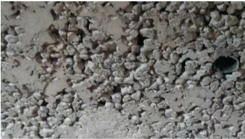
Hình 3 : khuyết tật rỗ bê tông
