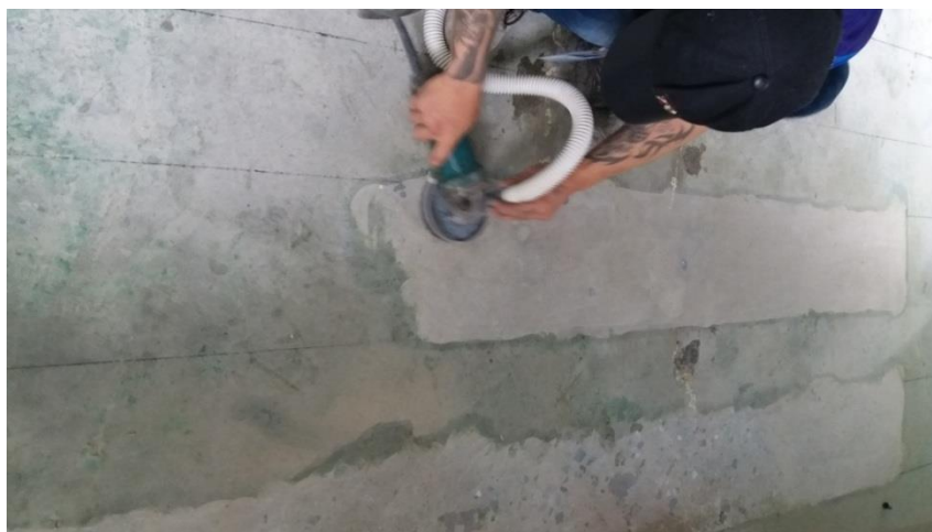
Hình 2- máy mài có chức năng hút bụi , tạo nhám và xử lý lỗi , lõm
