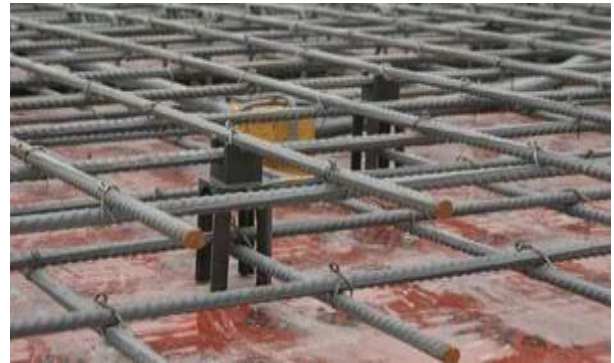
Hình 4 : cục kê lớp thép trên rất hợp lý
