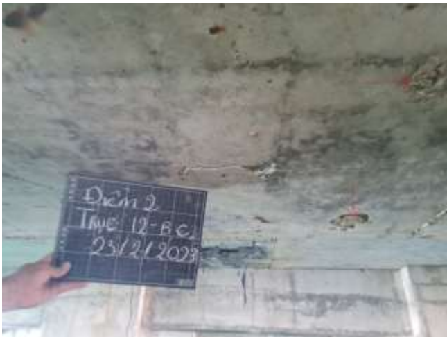
Hình 1: cục kê thép có cường độ thấp , thép bị rỉ sớm
