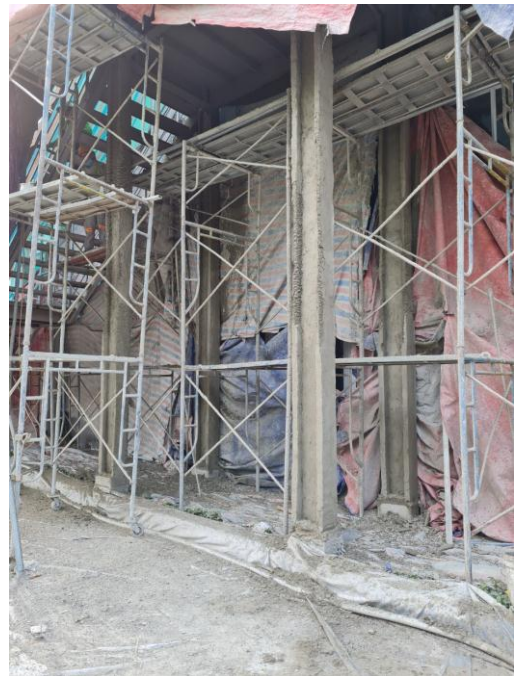
Hình 2 : Đang phun vữa chống cháy cho cầu thang ngoài nhà
