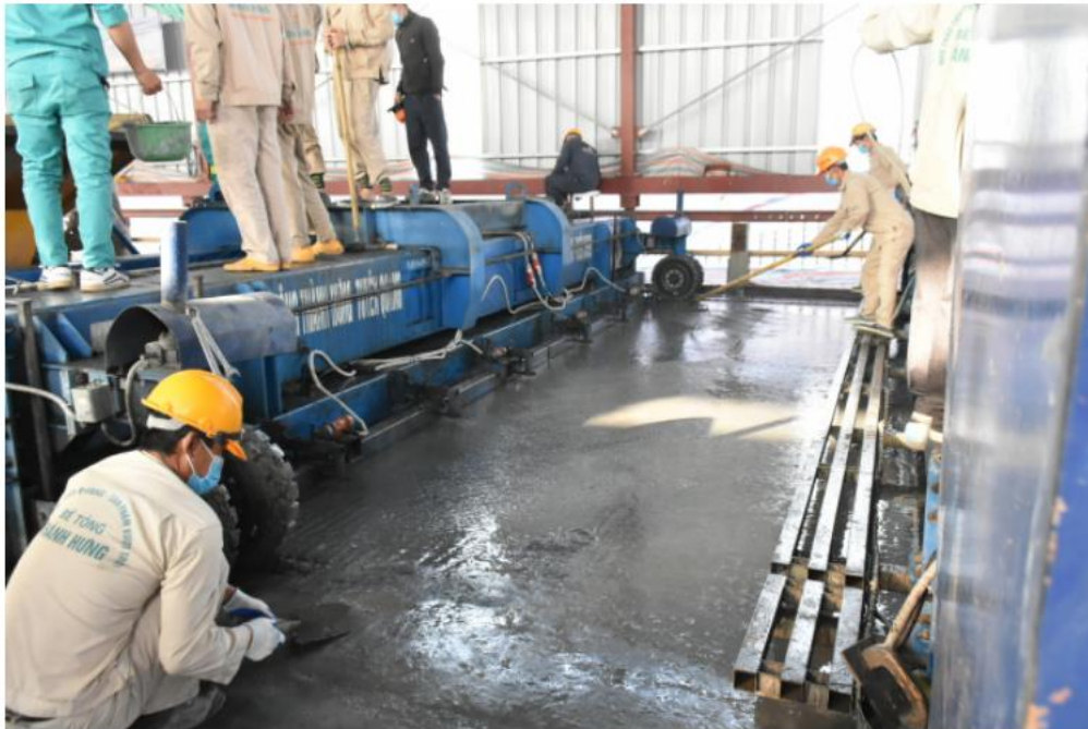
Hình 6: Thi công bê tông UHPC mặt cầu Thăng Long 12-2020
