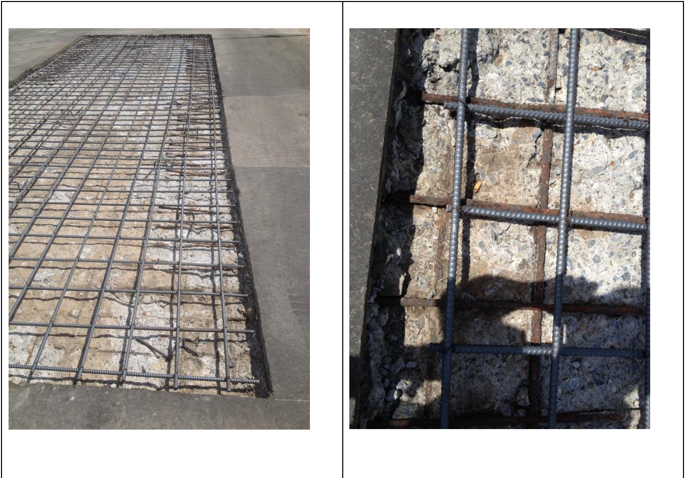
Hình 1: Hiện trạng hư hỏng và chuẩn bị đổ lớp bê tông truyền thống để sửa chữa
