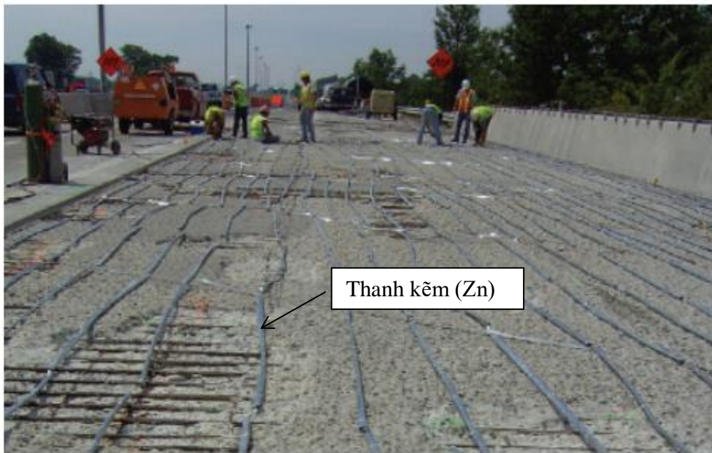
Hình 8: Dùng phương pháp điện hóa kết hợp với bê tông sửa chữa để ngăn chặn ăn mòn
