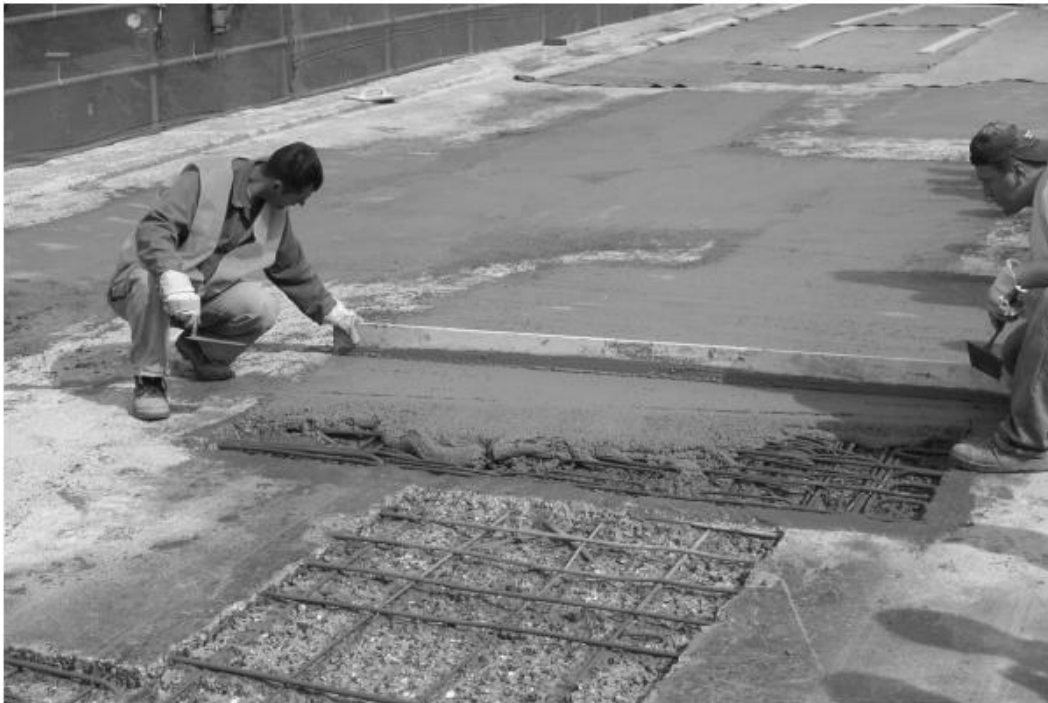
Hình 4: Thi công lớp vữa epoxy
