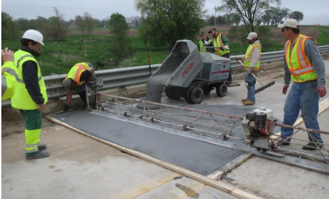
Hình 5: Đang thi công lớp vữa UHPC – Hoa Kỳ 2016
