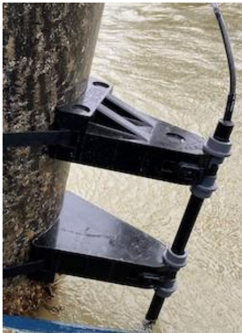
Hình 1: Hệ thống anode cho phương pháp dòng điện ngoài
