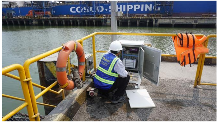
Hình 5 : Kiểm tra thiết bị ngăn chặn ăn mòn tại cảng Phú Mỹ
