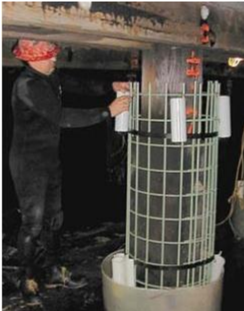
Hình 5: Gia cố cọc bằng lớp bê tông cốt FRP kết hợp với tấm pile jacket
