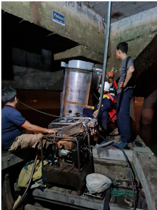
Hình 11 : Lắp ráp pha thành , dây bơm vữa
