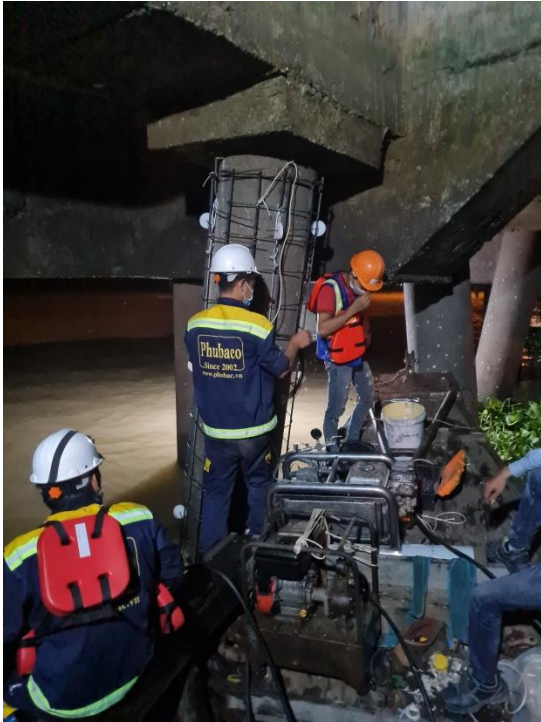
Hình 3 : đang lắp ráp cốt thép vào cọc UST cần gia cố
