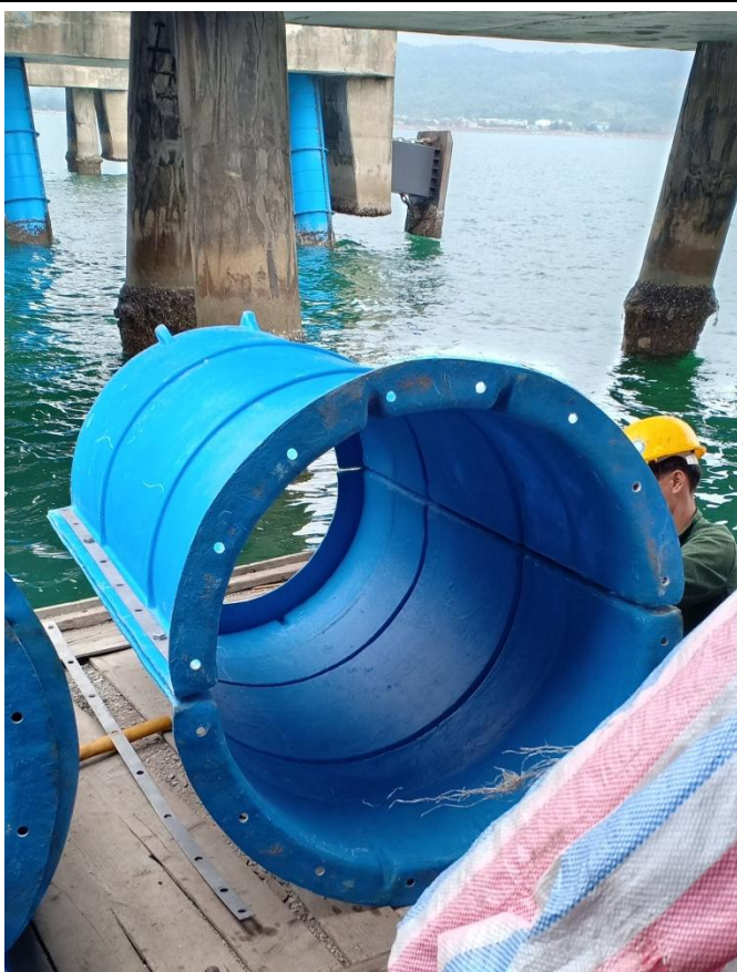
Hình 7: Cốt pha composite
