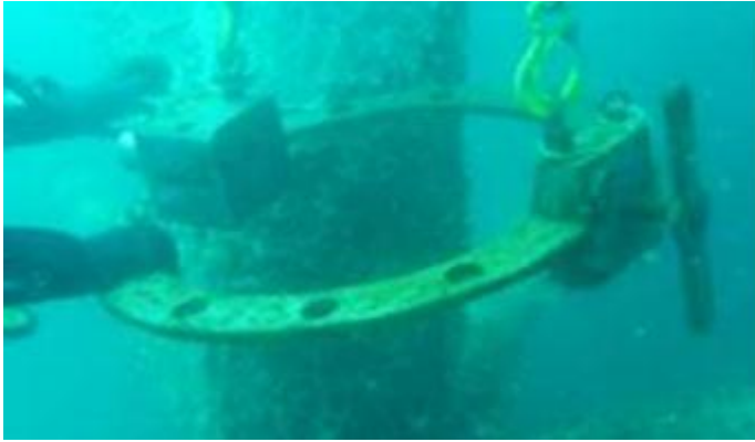
Hình 9 : thợ lặn đang lắp đặt tấm đáy
