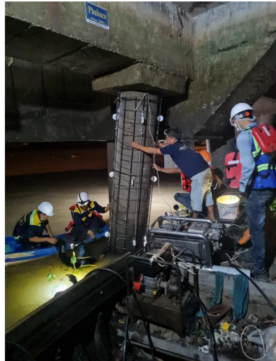
Hình 12 : Lắp ráp cốt thép , cục kê
