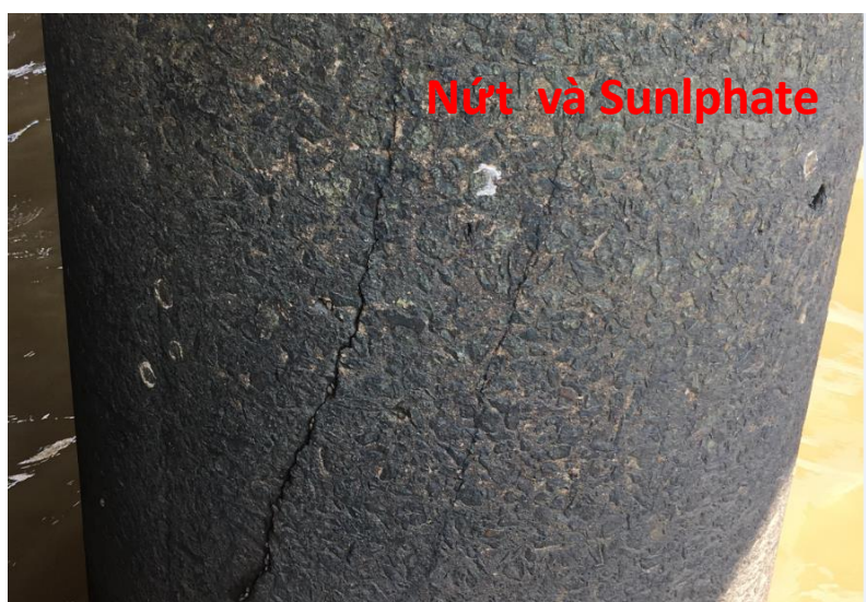
Hình 2 : Cọc UST sau 7 năm sử dụng - xuất hiện nhiều vết nứt (Quảng Ninh )
