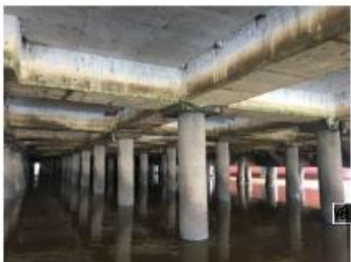
Hình 2 : Cọc UST sau 7 năm sử dụng - xuất hiện nhiều vết nứt (Quảng Ninh )
