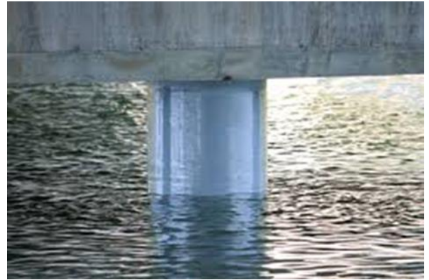
Hình 4 : Bọc cọc bằng tấm FRP vào cọc cảng
