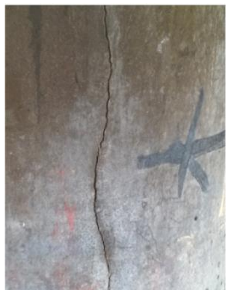
Hình 2 : Vết nứt rộng 2 mm
