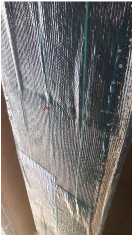
Hình 1 : Chất lượng thi công kém
