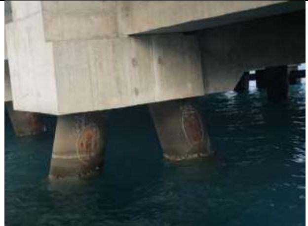
Hình 2 : Cốp pha kín , bề mặt đặc chắc
