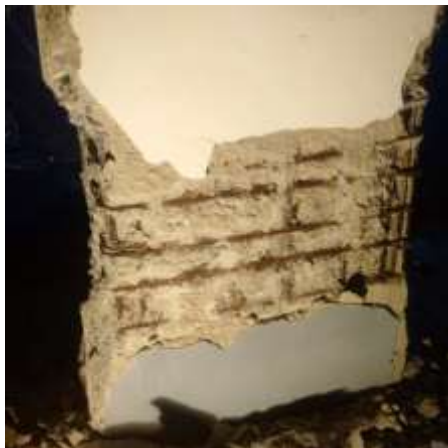
Hình 3 : dùng thép thay cục kê bằng bê tông
