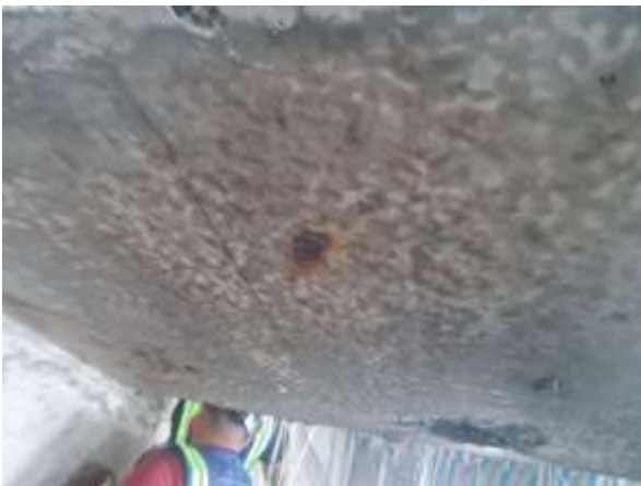
Hình 3 : dùng thép thay cục kê bằng bê tông
