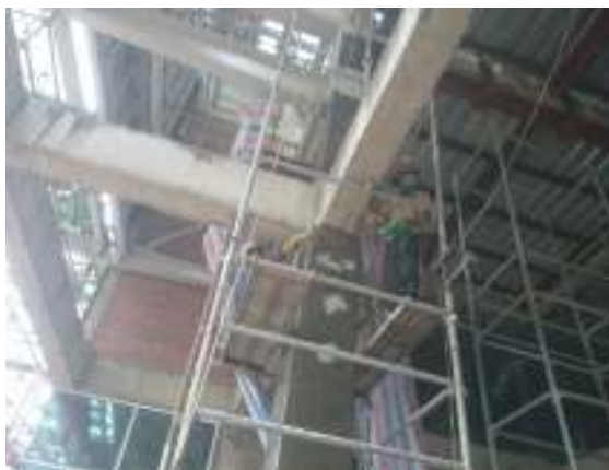
Hình 8 : Trám trét lỗ mọt và tạo phẳng
