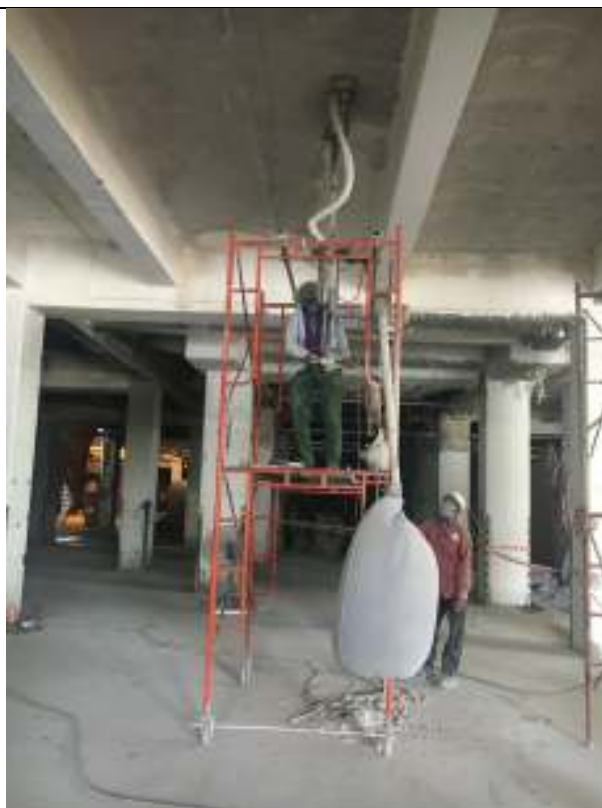
Hình 5: Mài đáy sàn , dầm bằng robot
