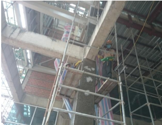
Hình 8 : Trám trét lỗ mọt và tạo phẳng
