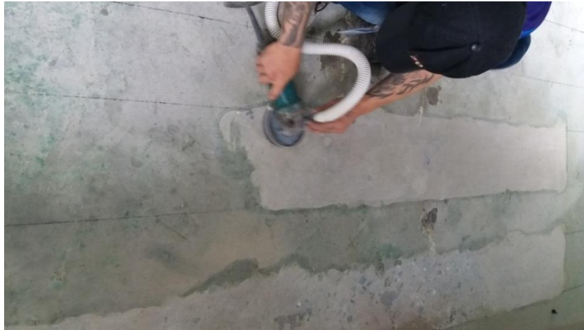
Hình 2- máy mài có chức năng hút bụi , tạo nhám và xử lý lồi , lõm
