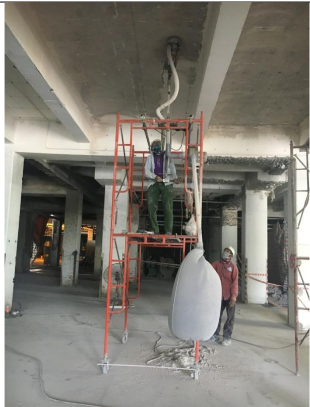
Hình 5: Mài đáy sàn , dầm bằng robot
