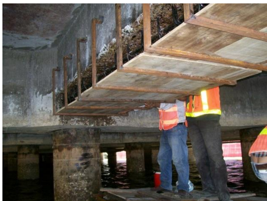
Hình 11: Bơm bê tông đáy đầm
