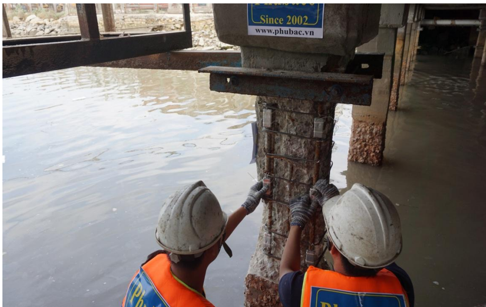
Hình 23 : đục bê tông và lắp đặt anode
