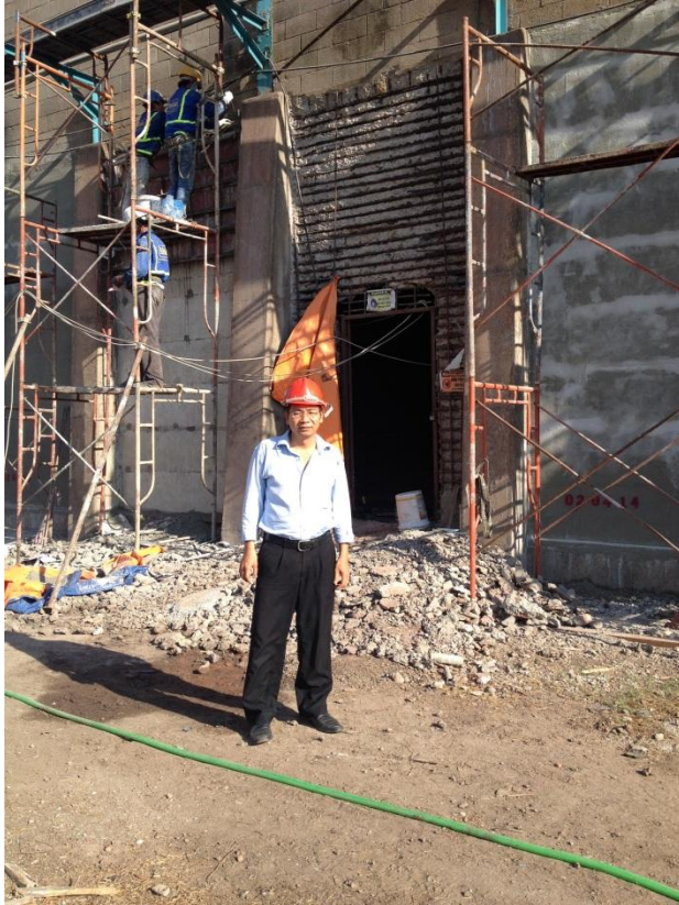
Hình 12: đang đổ bê tông tường
