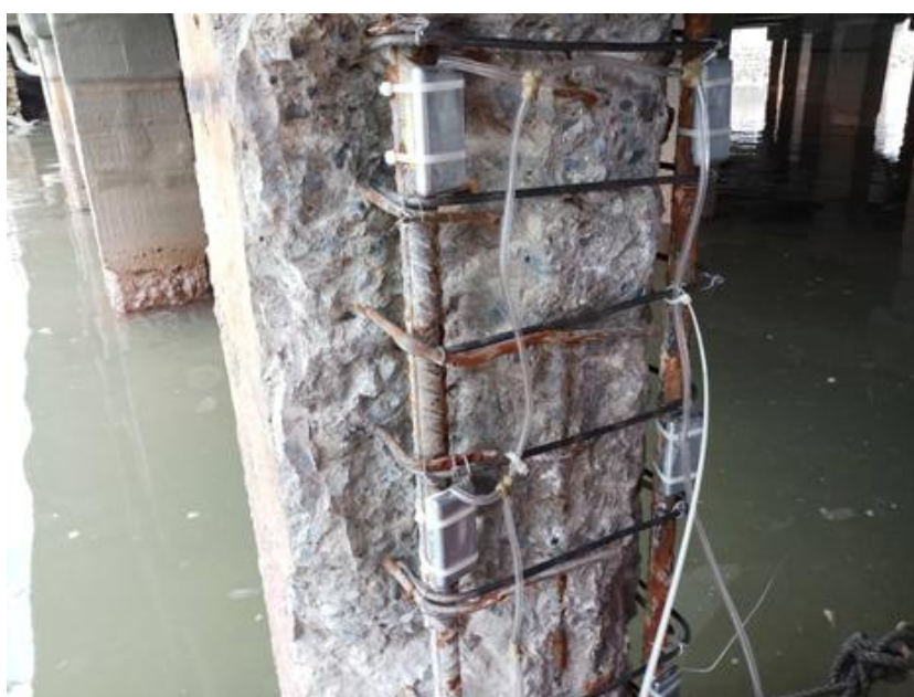
Hình 24 : Lắp đặt dây dẫn điện
