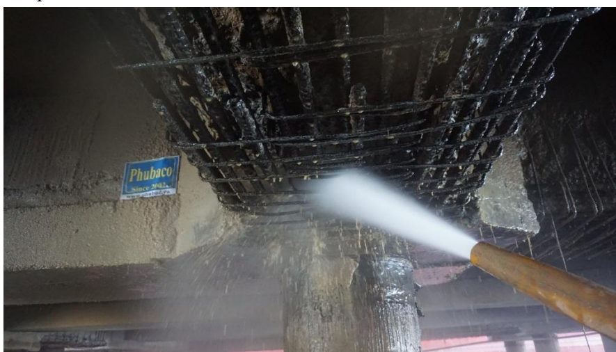
Hình 8 : máy đánh gỉ bằng cát kết hợp nước
