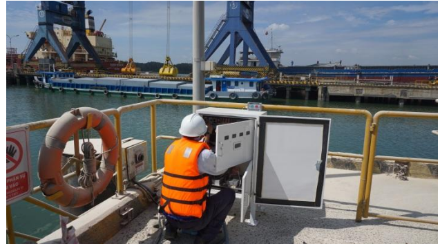
Hình 19- Đang kiểm tra thiết bị
