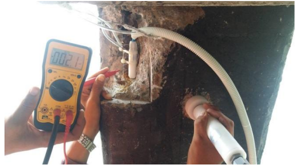
Hình 17: Chôn điện cực so sánh trong bê tông
