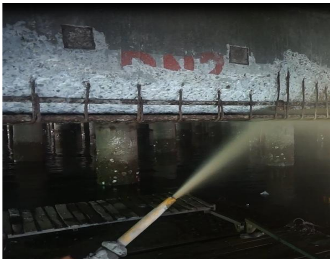
Hình 9 : đang phun bê tông
