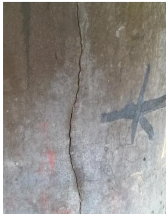
Hình 2: Cọc bị nứt do thép bị ăn mòn sau 7 năm sử dụng
