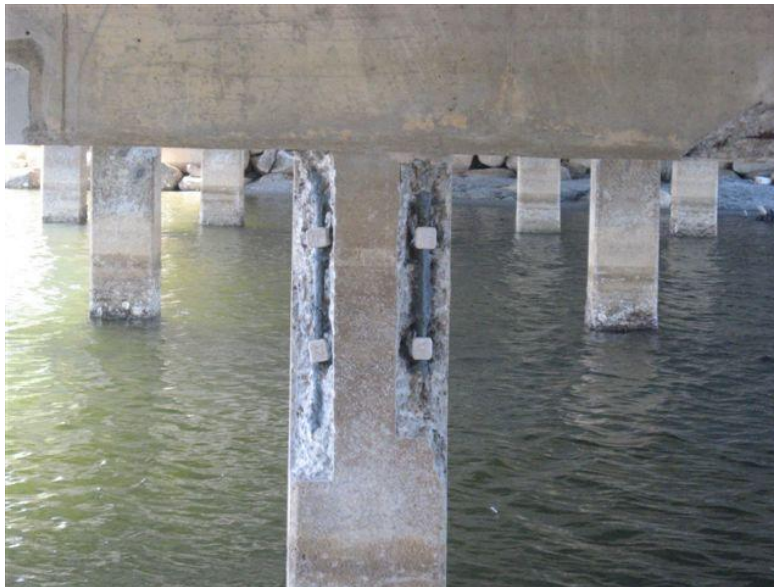
Gắn thiết bị chống ăn mòn cho cọc cầu cảng
