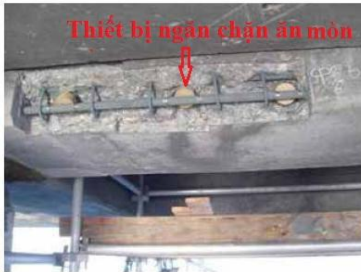
Gắn thiết bị chống ăn mòn cho dầm cầu
