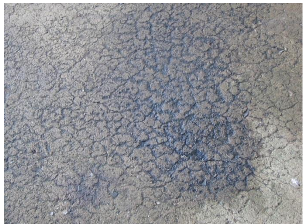
Hình 5 : Bê tông nền bị nứt và lở
