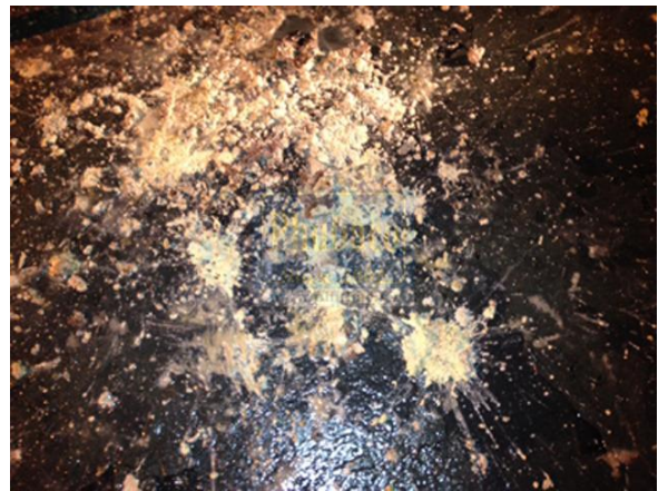
Hình 2 : Vữa trong bê tông bị mục
