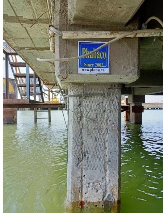
Hình 4 : Gắn anode Titan
