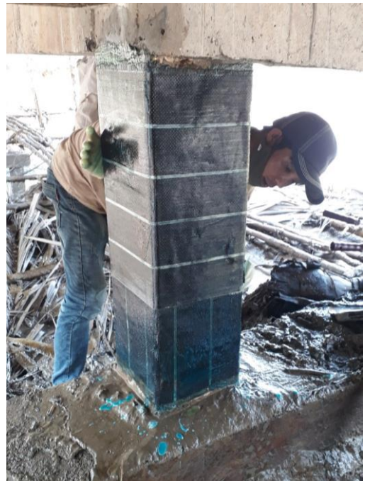
Hình 6 : Bọc sợi FRP
