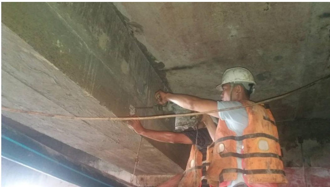
Hình 5 : Khoan lấy bột bê tông để thí nghiệm hàm lượng ion clorua
