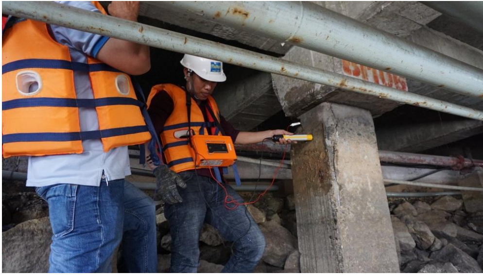
Hình 4 ; Đo điện thế ăn mòn
