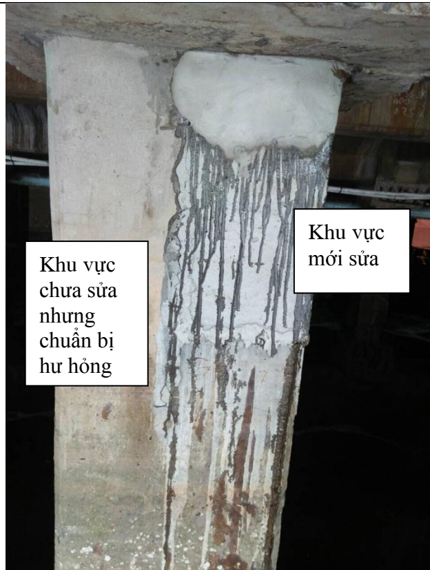
Hình 3 : Tái lập cọc cầu cảng
