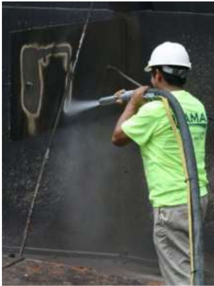
Đánh rỉ bằng máy nén khí + cát + nước
