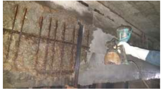
Phun lớp epoxy Maxepox Bond-S
