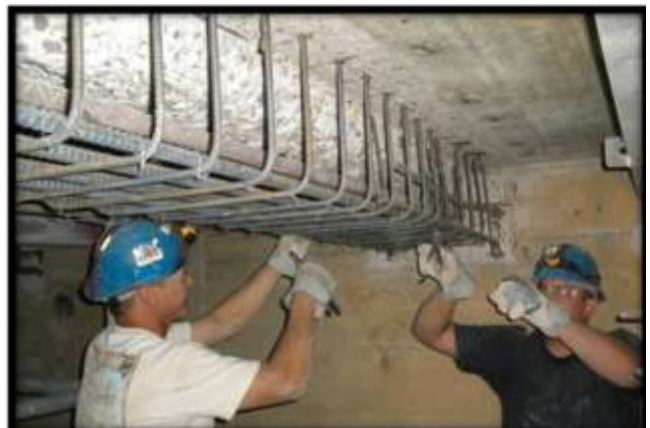
Khoan cấy thép vào bê tông
