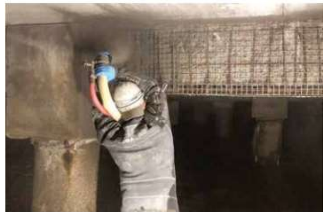
Phun bê tông thành dầm
