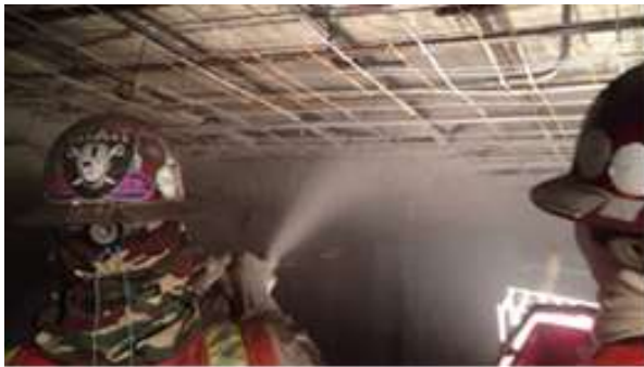
Phun bê tông đáy sàn
