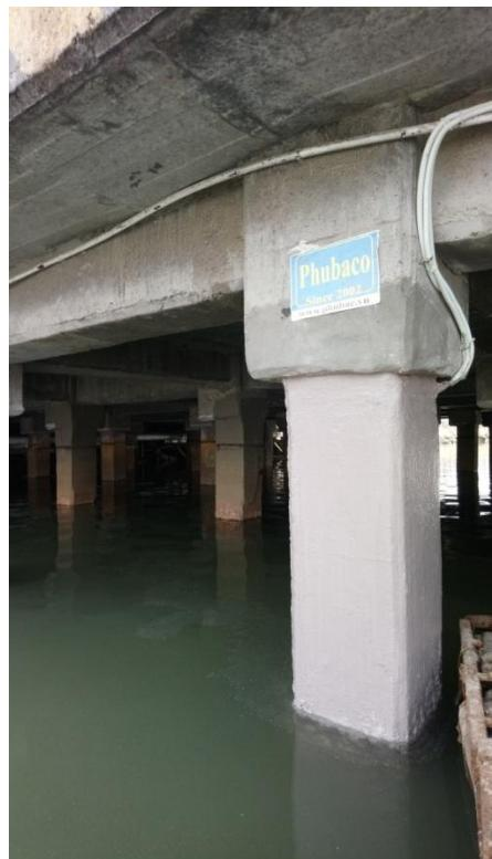
Hình 21 : Hoàn thiện bằng lớp chống thấm
