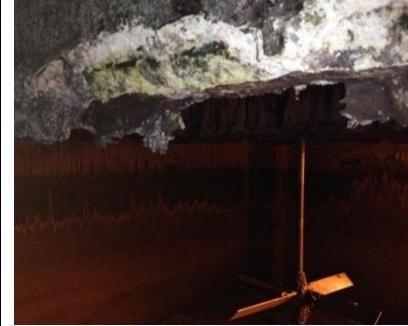
Hình 4 : Ăn mòn trong bể xử lý nước thải kín , bê tông bị mục nát
