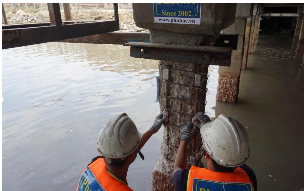
Hình 23 : đúc bê tông và lắp đặt anode
