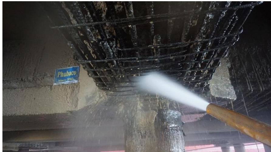
Hình 8 : máy đánh giã bằng cát kết hợp nước
