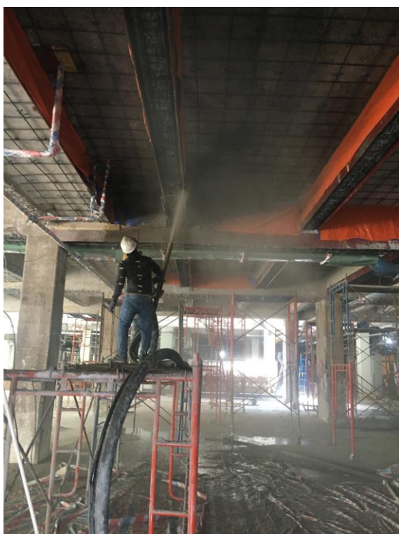
PHUN BÊ TÔNG NHÀ XƯỞNG
