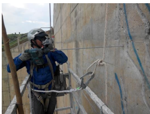
KHOAN BƠM KEO XỬ LÝ NỨT ĐẬP THỦY ĐIỆN
