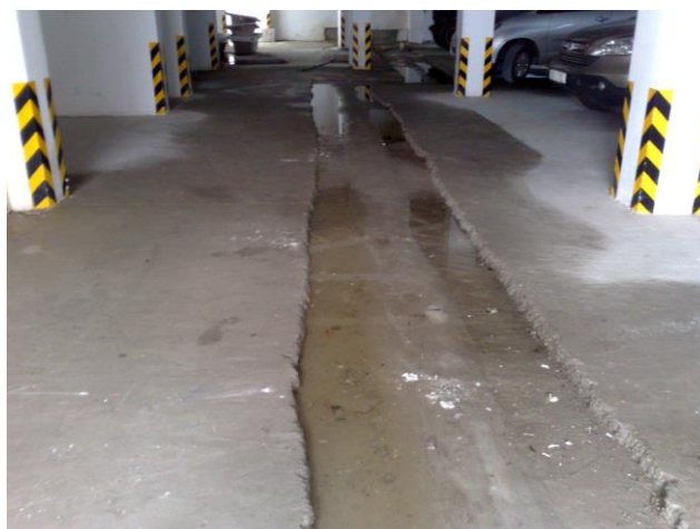
RÒ RỈ KHE CO GIÃN TẦNG HẦM
