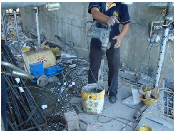
BƠM CHÈN KHE HỖ BÊ TÔNG
