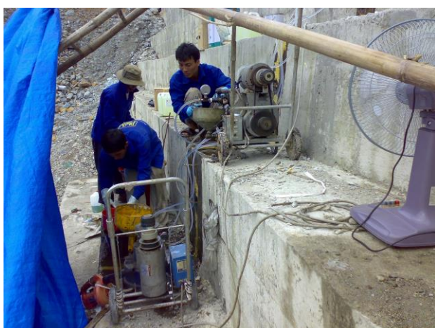
NỨT HÀNH LANG THỦY ĐIỆN
