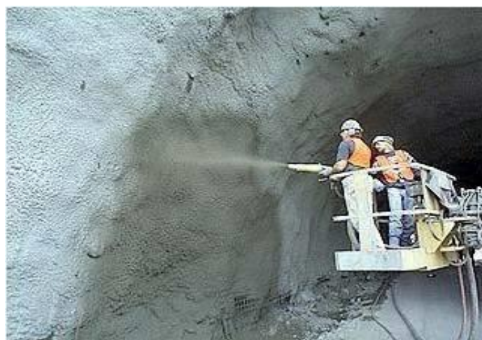
PHUN BÊ TÔNG ĐƯỜNG HẦM
