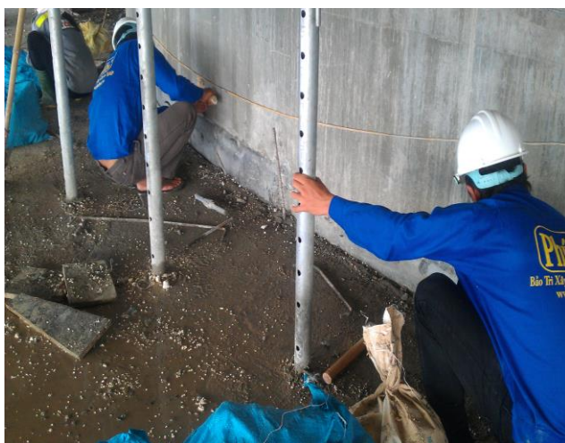
BƠM KEO XỬ LÝ KHE HỖ
