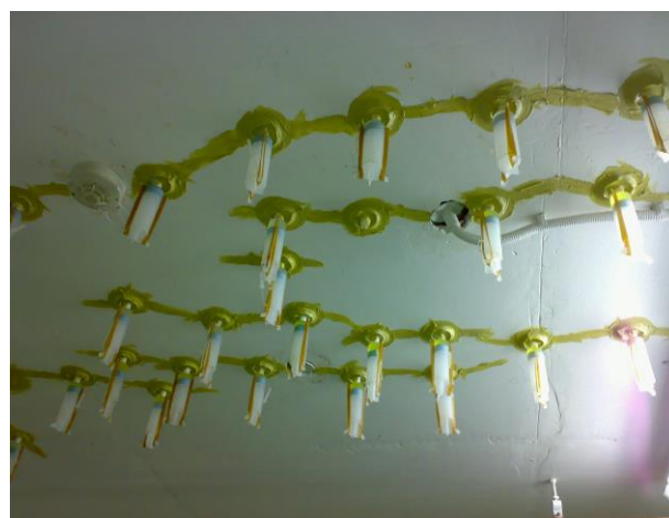
NỨT BÊ TÔNG SÀN NHÀ
