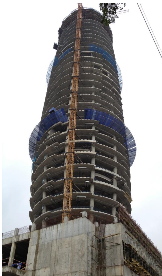
CÔNG TRÌNH ĐANG THI CÔNG
