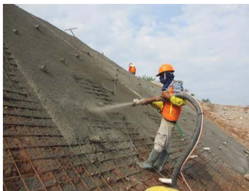
PHUN BÊ TÔNG MÁI TALUY
