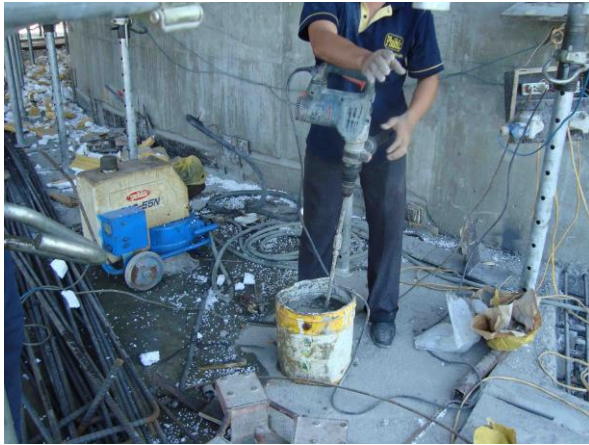
BƠM CHÈN KHE HỖ BÊ TÔNG
