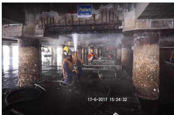
PHUN BÊ TÔNG GÀM CẦU CẢNG
