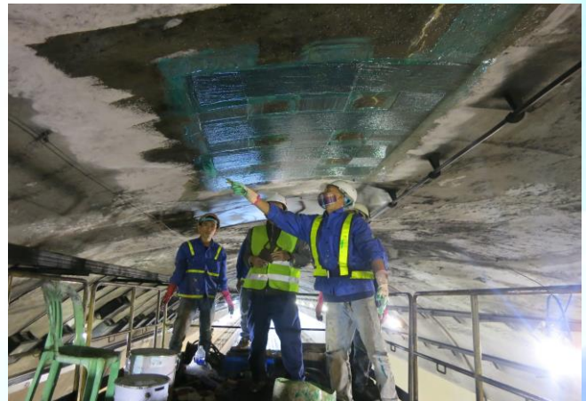
DÁN SỢI CARBON ĐƯỜNG HẦM
