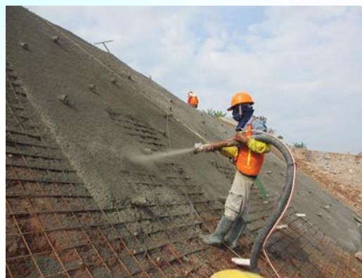
PHUN BÊ TÔNG MÁI TALUY
