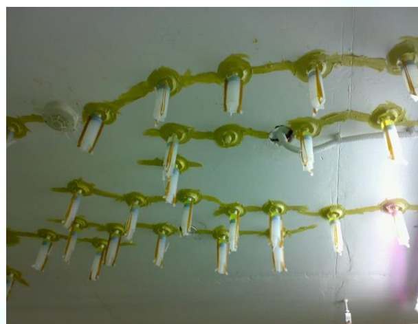
NÚT BÊ TÔNG SÀN NHÀ
