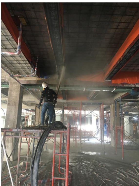
PHUN BÊ TÔNG NHÀ XƯỞNG
