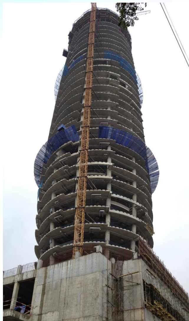
CÔNG TRÌNH ĐANG THI CÔNG
